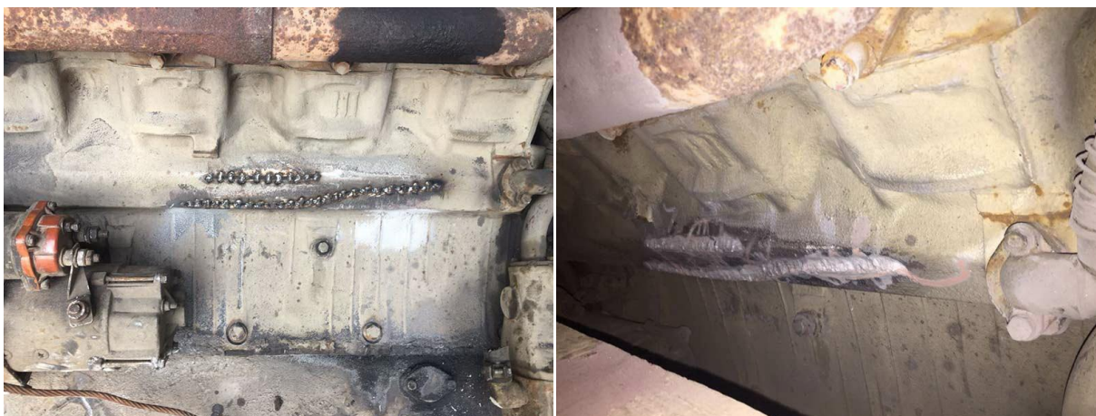
Рис. 8. Превращение трещины в набор отверстий и герметизация напылением.
